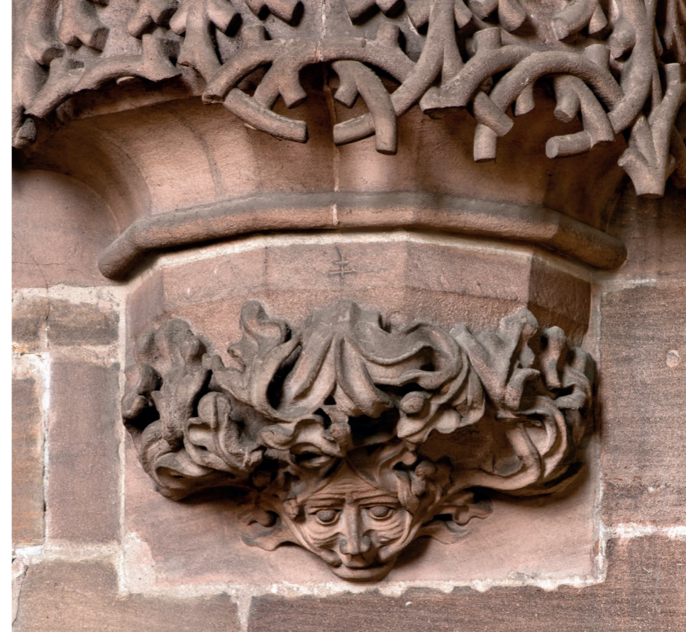
Blattmaske am nördlichen Hallenchorpfeiler oben
